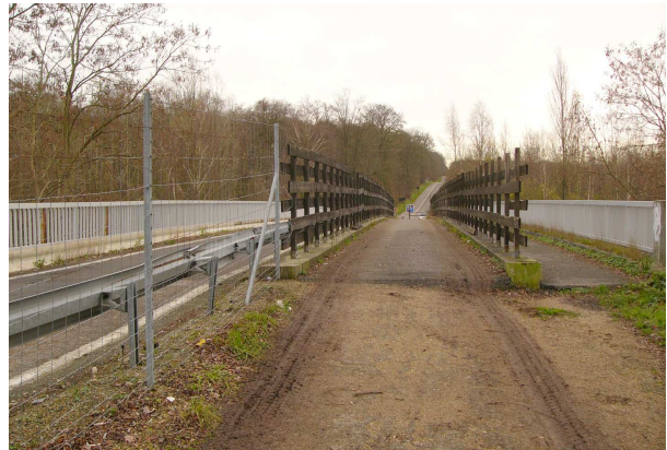
RN184, passage supérieur composé d'une sortie routière sur la RD9, une piste cavalière et un passage piéton « Carrefour de la Porte Baillet » vue vers l'Est.
