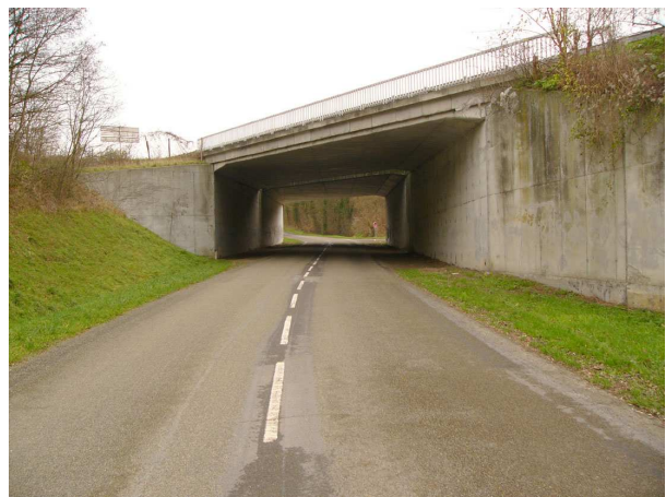
RN184, passage inférieur pour la RD9 au niveau de la connexion avec la RN104.
