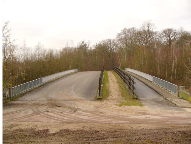
RN184, passage supérieur pour camion de débardage, une piste cavalière et une voie piéton « Carrefour du Tremble ».
