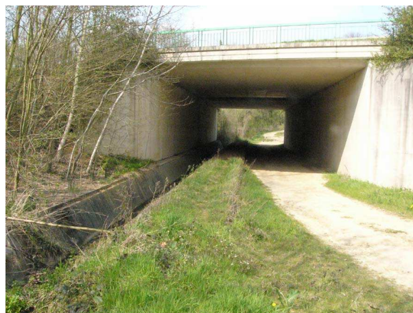
RN104, ouvrage n°2, passage inférieur mixte faune-hydraulique de la Côte des Hauts-Buis.
