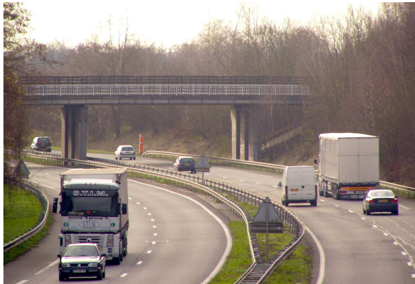
RN184, passage du Carrefour du Tremble vu de la Porte de la Croix l'Abbé.
