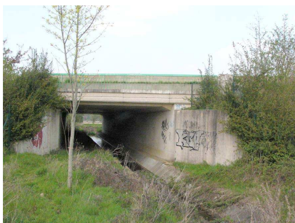
RN104, ouvrage n°3, passage inférieur mixte faune-hydraulique au ru de Chauvry.
