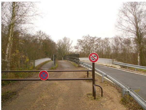
RN184, passage supérieur composé d'une sortie routière sur la RD9, une piste cavalière et un passage piéton « Carrefour de la Porte Baillet » vue vers l'Ouest.
