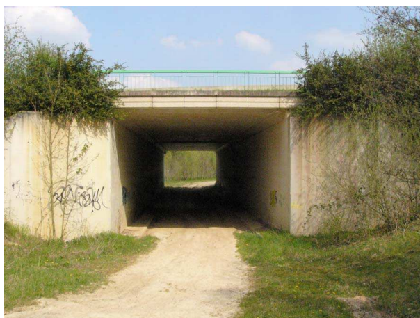
RN104, ouvrage n°1, passage inférieur des Saules.
