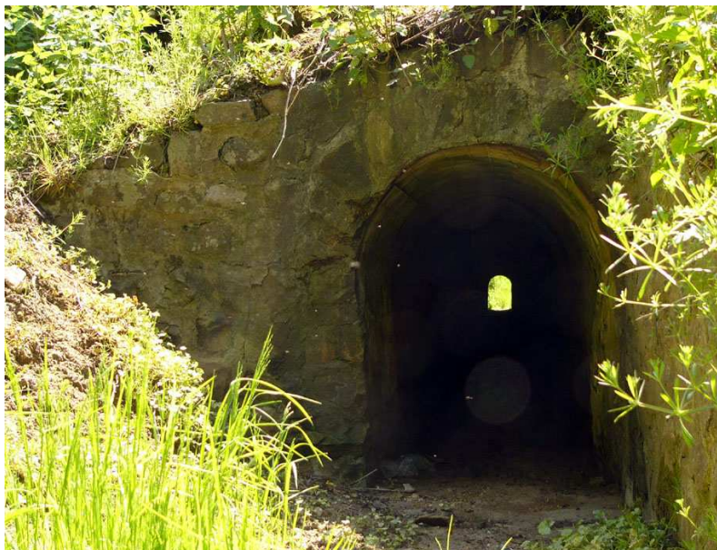
Ouvrage hydraulique au niveau du point bas de la RN1 à la traversée du Bois Carreau.
