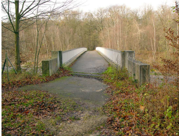
RN184, passerelle supérieure pour piéton « Porte de la Croix l'Abbé ».
