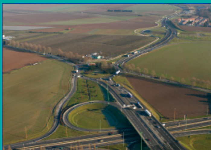
Le carrefour de la Croix-Verte : un échangeur dénivelé et un giratoire sur la Francilienne.
