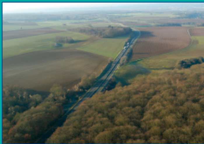
Traversée de la RN1 au niveau du Bois Carreau.
