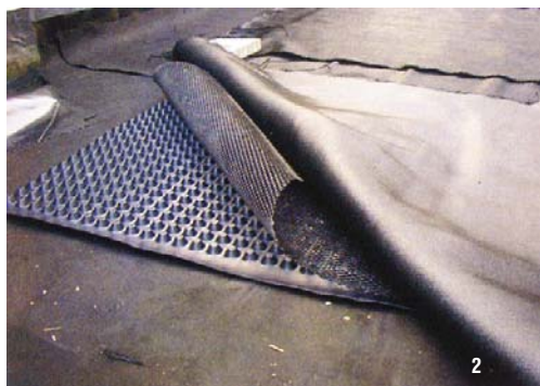
1 : toit végétalisé avec installation photovoltaïque sur une école à Unterensingen, Allemagne - 2 : système de drainage sur isolation de toiture avant installation du substrat et de la végétation
