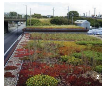
2 : toit de sedums et vivaces sur substrat extensif à Gennevilliers réalisé en 1990
