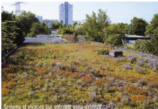
Sedums et vivaces sur substrat semi-extensif
