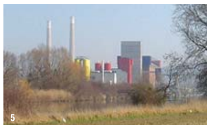
1 : gabarit homogène et horizontal autour de la darse 2 : volumes imbriqués de Prism'O - 3 : volumes percés de Ferinox - 4 : toits façade d'UCAYC 5 : composition verticale sur la façade fluviale
