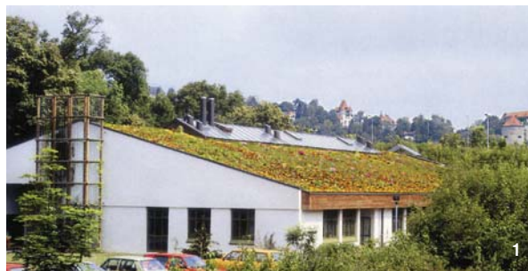
1 : toit penté et végétalisé dans une zone d'activités 'standard'
