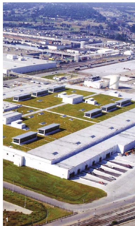
1 : toit végétalisé de l'usine Ford dans le Michigan, l'un des plus grands au monde (4.2ha)
