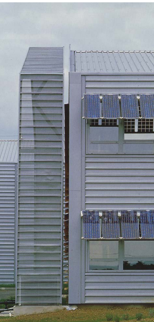
1 : bris solaire en panneaux photovoltaïques des bureaux de Total Energie à la Tour de Salvagny 2 : panneaux photovoltaïques en façade d'un lycée rénovée 3 : panneaux amorphes souples sur un entrepôt
