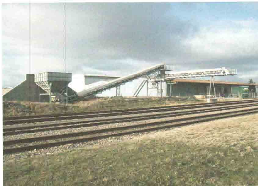
Photo n° 4 : APROPORT à MACON, Quai de chargement direct des trains en Ballast.
