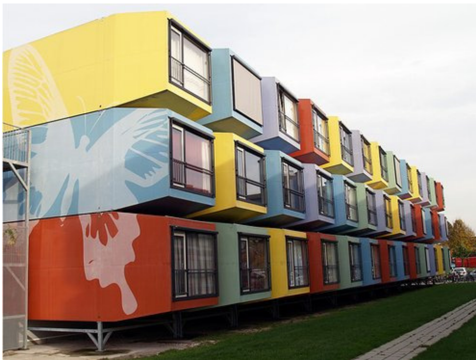
Illustration 1 : Les « Spacebox », des conteneurs "logement étudiant" au sein du campus universitaire d'Utrecht.
