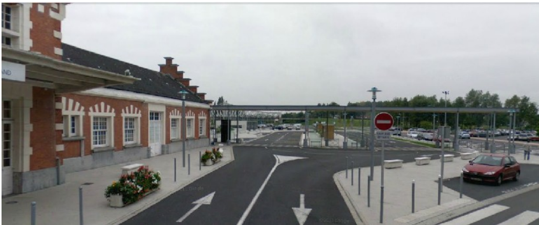
Illustration 183: Parc-relais aménagé sur la gare de St Amand les Eaux - source : google maps 2011
