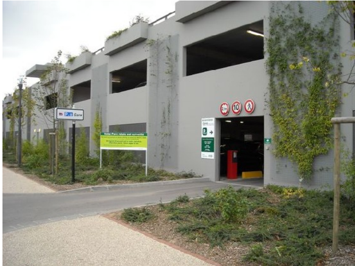
Illustration 126: Le P+R du pôle d'échanges d'Armentières - source : photo CETE Nord Picardie
