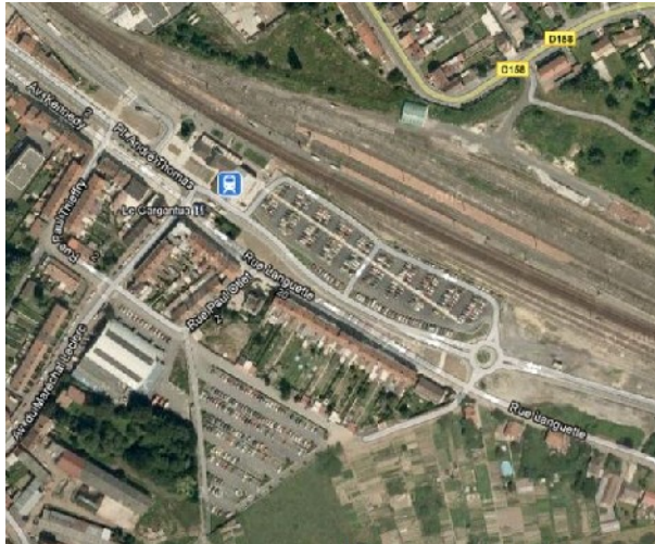
Illustration 80: Gare d'Orchies : P+R à droite du bâtiment gare et parking en retrait au sud – source : google maps
