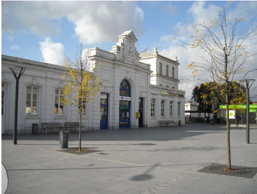
Illustration 123: La gare d'Armentières et son parvis - source : photo CETE Nord Picardie
