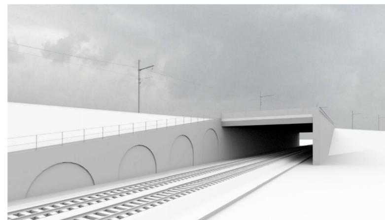
Des joints de structure sont prévus disposés à intervalles réguliers de manière à limiter les efforts de retrait du béton et de dilatation.
