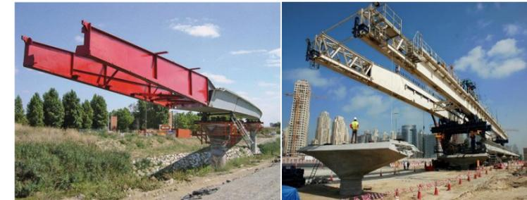
La cadence d'exécution des plots de dalle d'un pont mixte résulte, bien sûr, de critères économiques mais aussi de préoccupations visant à garantir la durabilité requise (résistance minimale au décoffrage, cure du béton, etc.).
