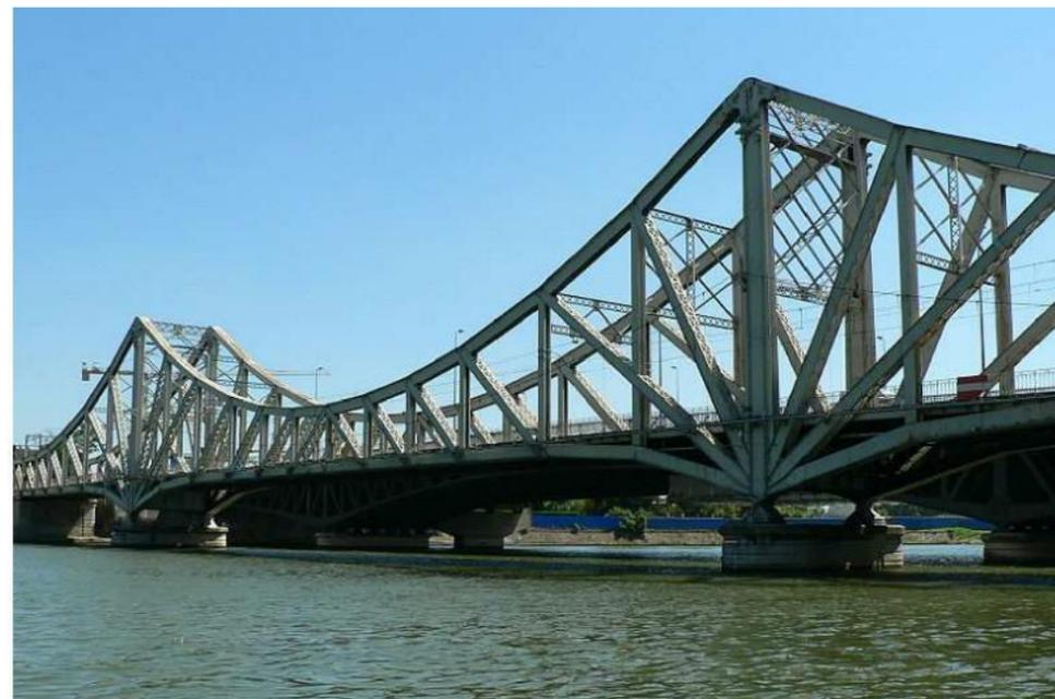
**Illustration 32.** Exemple d'ouvrage à poutres treillis à hauteur variable : Franchissement de la Saône à Lyon – Viaduc de la Mulatière
