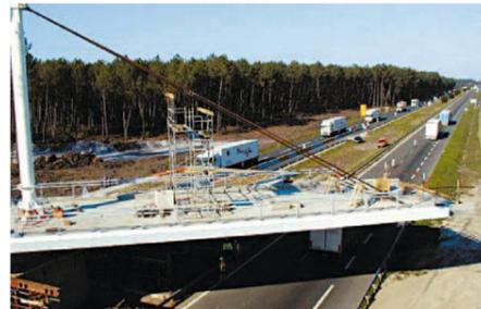
La rotation, effectuée rapidement, permet au tablier d'atteindre sa position définitive avec une gêne minimale pour les voies franchies.
