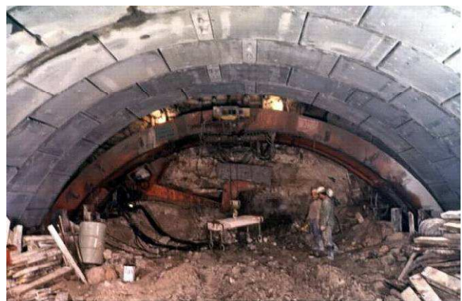
Schéma de la mise en place de la clé (à droite) – Mise en position d'un voussoir (à gauche)
