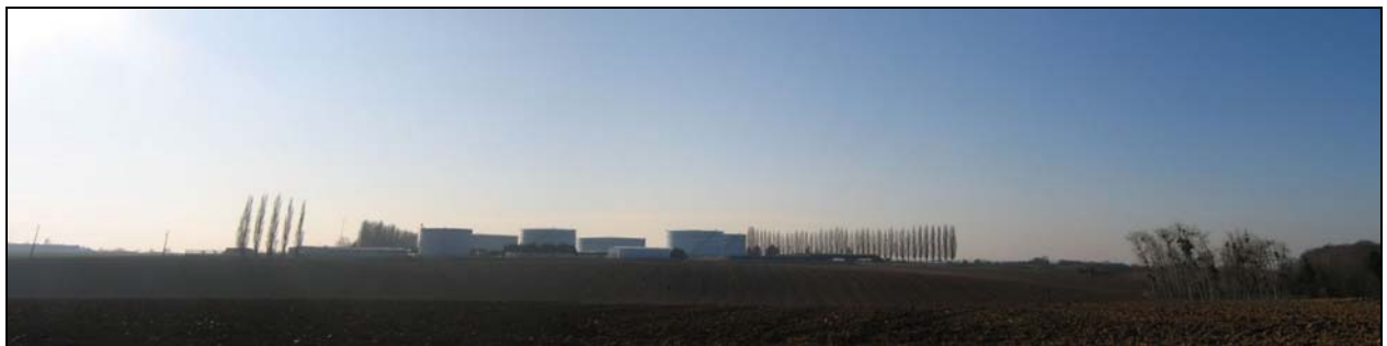
Photo 30 : Vue sur les réservoirs d'hydrocarbures à Chennevières-lès-Louvres (Source : Ingérop, 2009)
