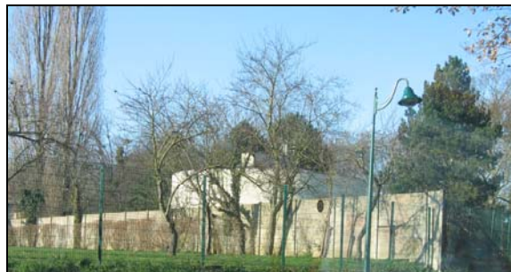
Photo 1 : Station de pompage de Vémars (source : Ingerop, 2009)
