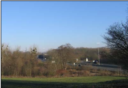
Photo 26 : Vue sur l'A1 depuis la RD9 à Villeron
