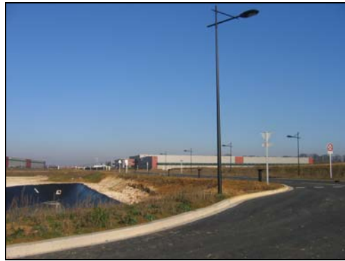
Photo 20 : ZAE en cours de réalisation (source : Ingerop, 2009)
