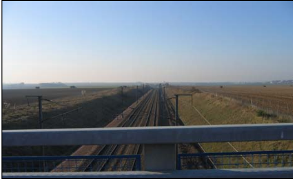
Photo 24 : vue sur la LGV Nord depuis la RD165E à Chennevières-lès-Louvres (source : Ingerop, 2009)
