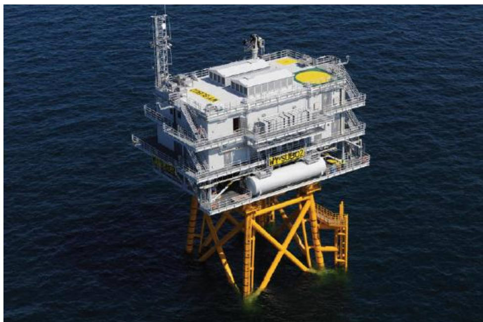
Figure 6 : Poste électrique en mer du parc éolien DONG Energy de Walney
