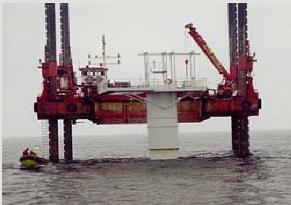
Installation des fondations
