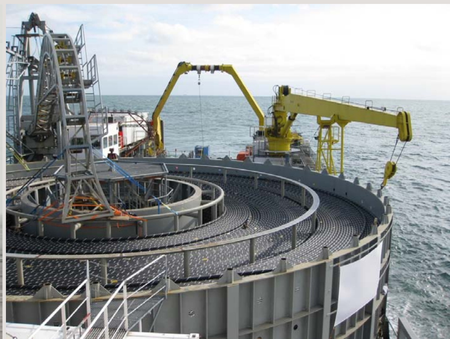
Installation des câbles
