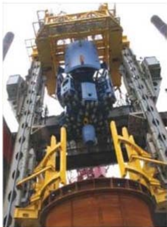
Forage en mer 6,8m de diamètre, chantier EDF
