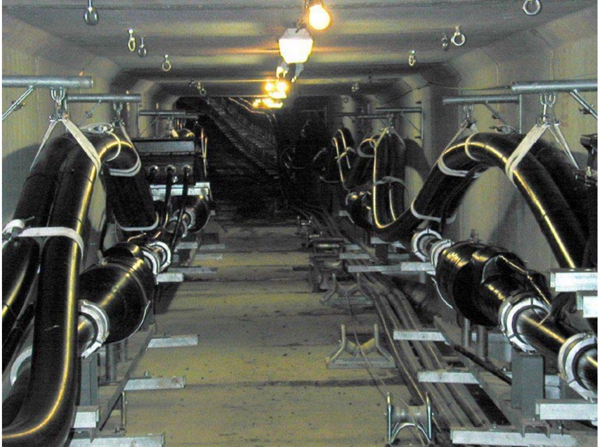
Galerie pour une liaison souterraine 400 000 V à Madrid
