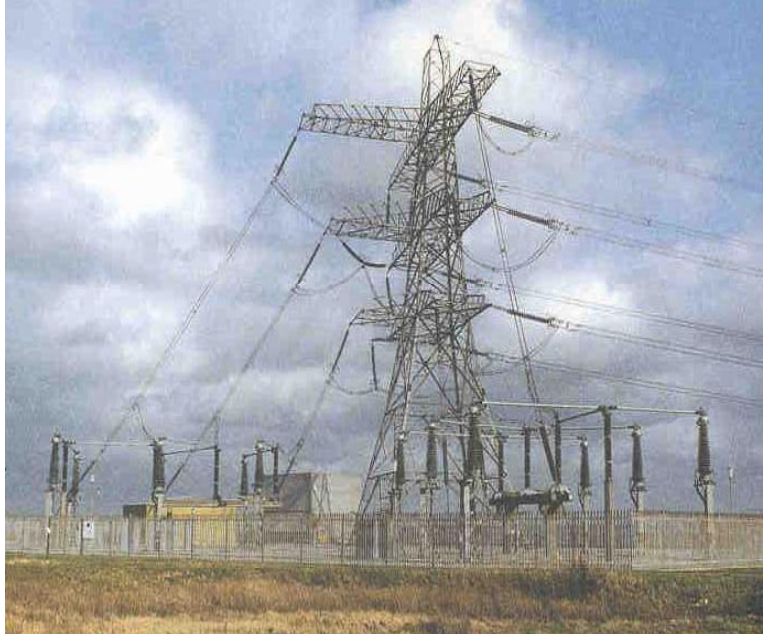
Poste aérosouterrain 400 000 volts en Angleterre
