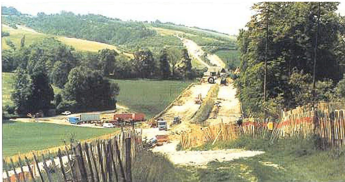
Fin du chantier d'une liaison 400 000 V en Angleterre (source : Sycabel)
