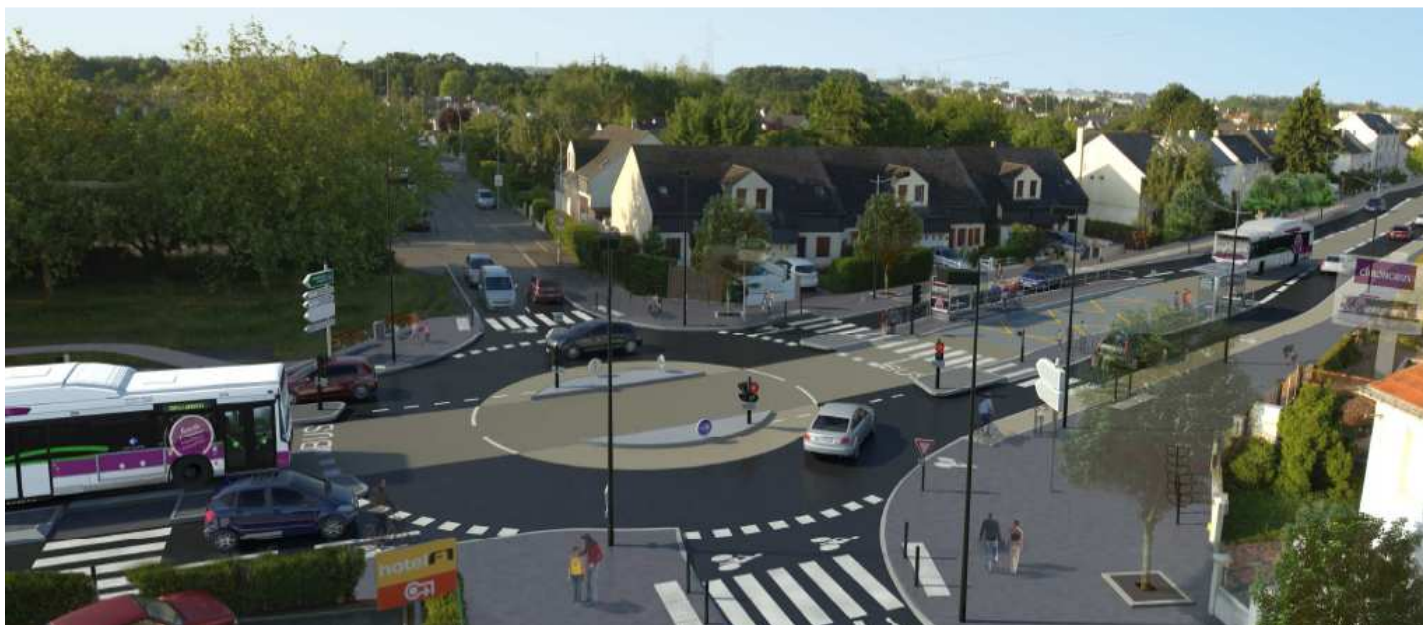
Figure 10 : Exemple d'aménagement de ronds-points percés avec signalisation (Nantes)
