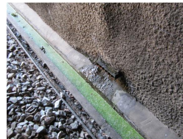
**Figure 23: complexe de drainage et de béton projeté**
