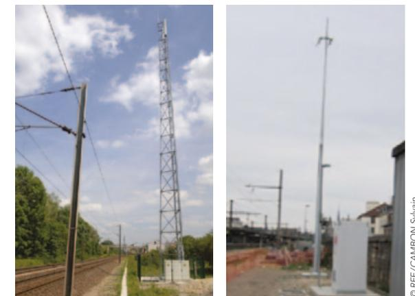
Exemples de mâts de télécommunication (treillis ou de type rabattable) implantés au bord des voies ferrées.
