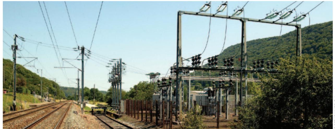
Sous-station électrique 25 000 Volts sur une ligne à double voie.
