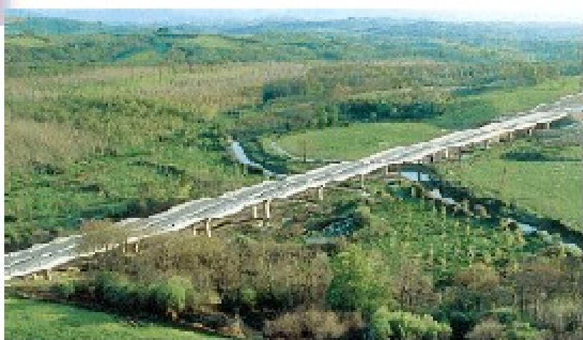
Franchissement d'une zone humide
